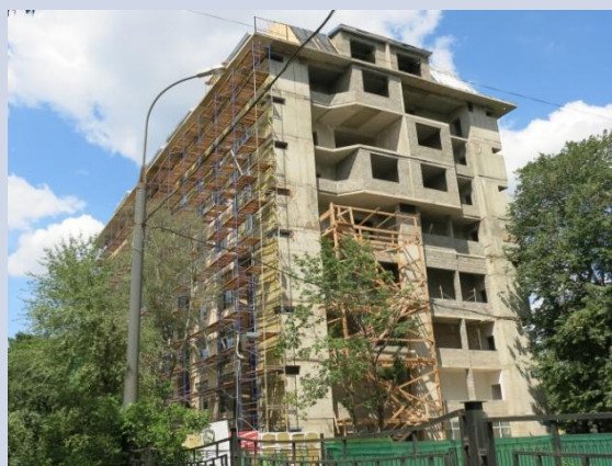
В процессе реконструкции
